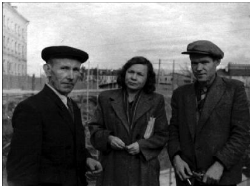
Э.П. Штольцер (автор проекта) со строителями на площадке строительства жилого дома в Пскове (ул. Ленина, д.1).
