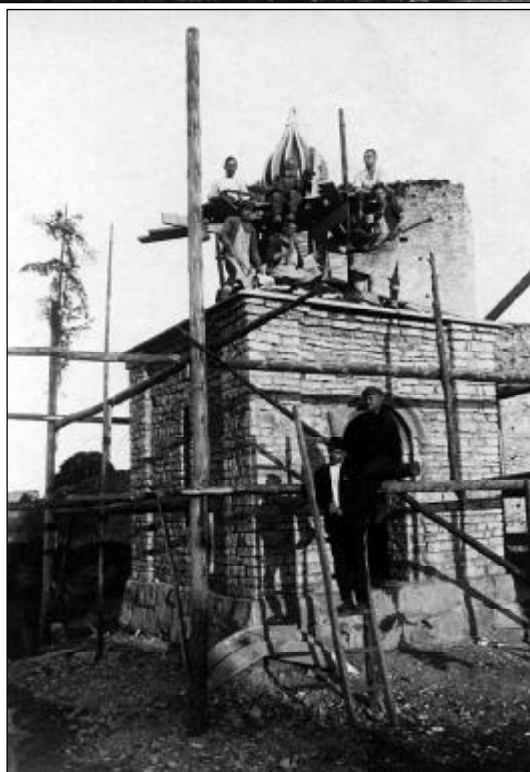
Г.И.Копьев на строительстве часовни Корсунской Божьей Матери (стоит на лестнице), Изборск, 1927 г.
