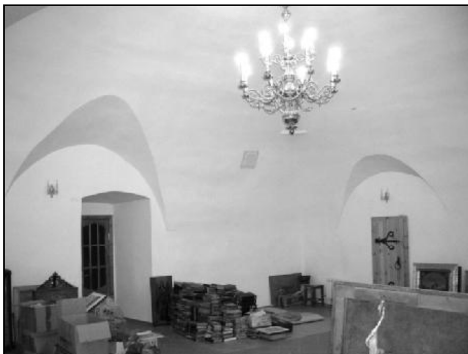
Северо-западный угол палаты второго этажа колокольни Троицкого собора
